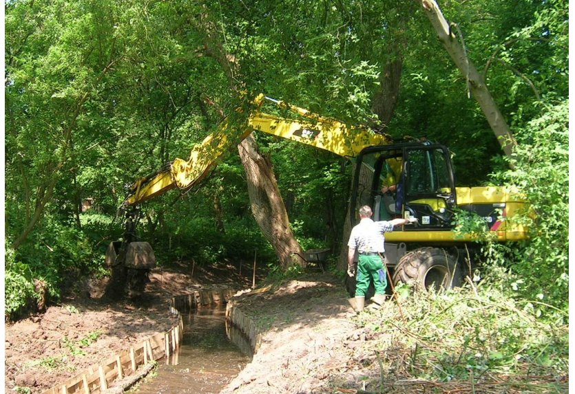
Schwierige Gewässerentschlammung an der Ihle zur Sicherstellung des Abflusses
