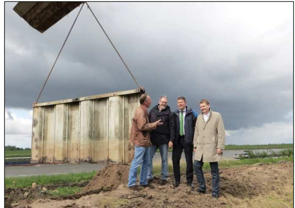
Erster „Spatenstich“ im Werderland v.r.: Ortsamtsleiter Boehlke, Senator Dr. Lohse, Deichhauptmann Dr. Schirmer, Geschäftsführer Döscher
