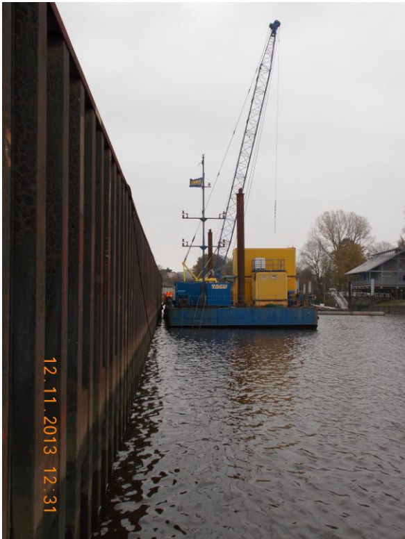
Vorbereitung der Rammung einer neuen Hochwasserschutzwand in Rönnebeck
